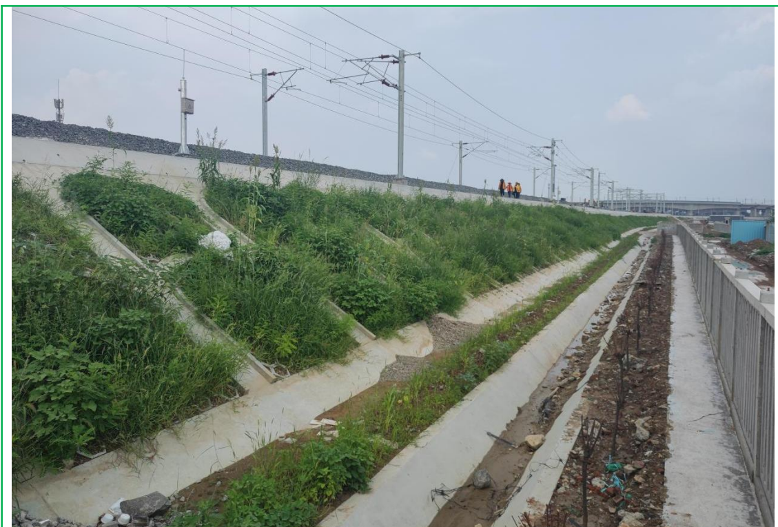
路基边坡防护、排水沟、绿化措施已完成
