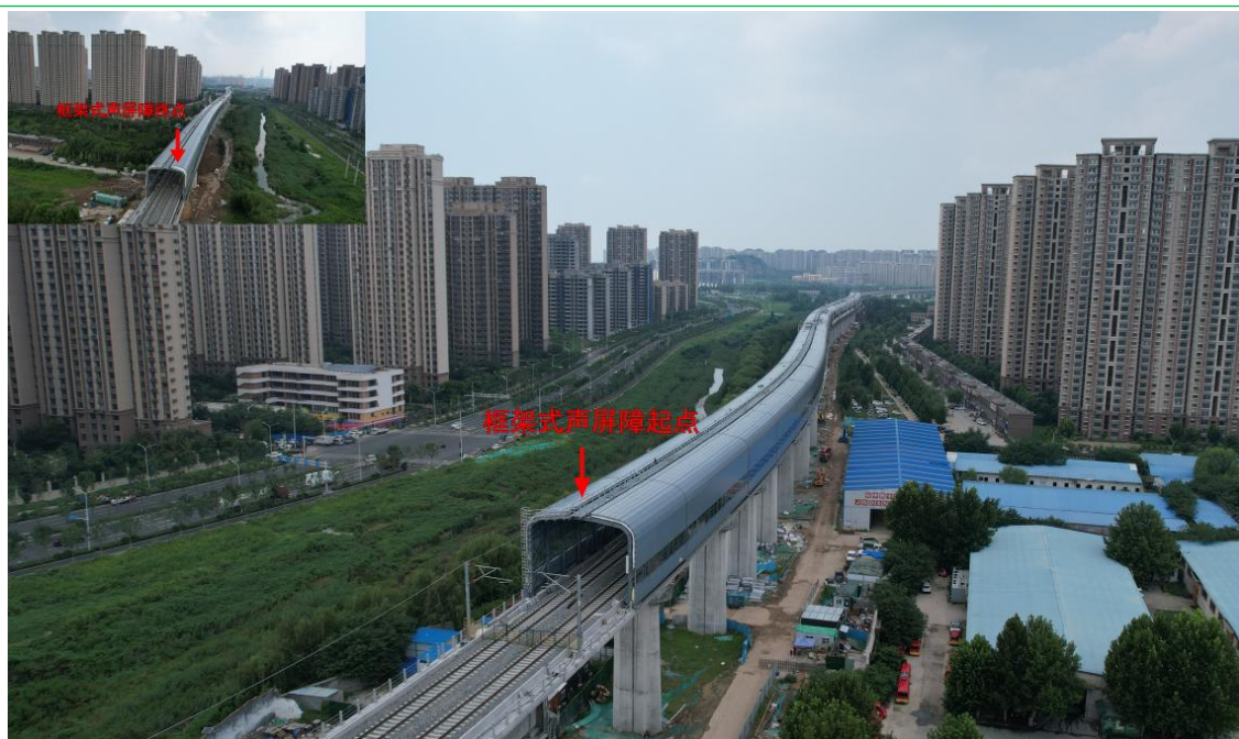
Y16 祥泰城阳光尚东、Y17 小天使幼儿园、Y18 大辛庄社区、Y19 祥泰城文澜苑、Y20 祥泰城悦公馆、Y21 祥泰城文璟园、Y22 大辛庄社区幼儿园
